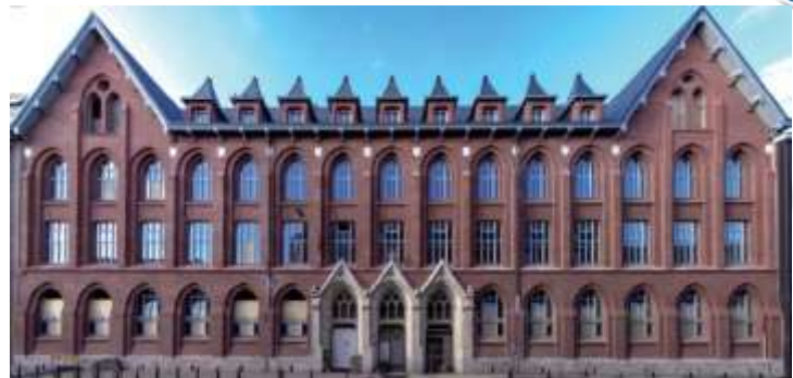
Bâtiment démonstrateur HEI-École des Hautes Études d'Ingénieur
